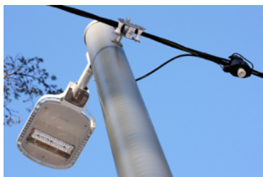
Armatyr med konsol direkt på stolpen
