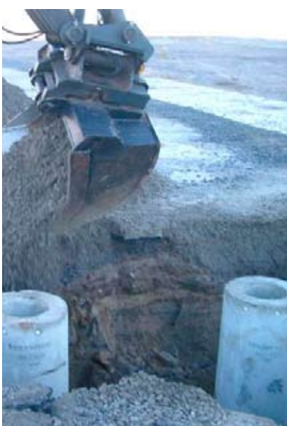
Krossgrus 0-45 som återfyllnadsmaterial
