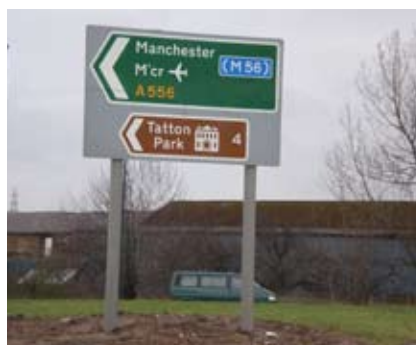
Skylt uppsatt på Jerolstolpar
