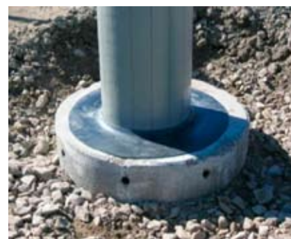
Fundamentet täcks med återfyllnadsmaterial
