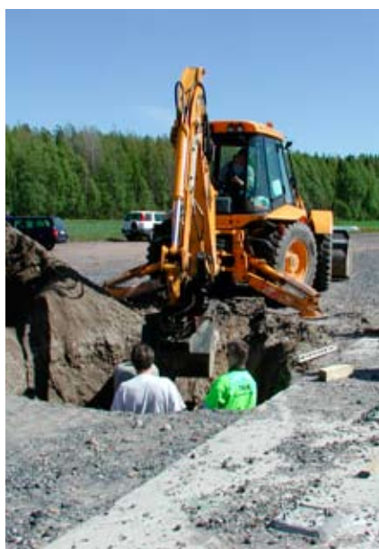
Installation av Jerol skyltstolpe
