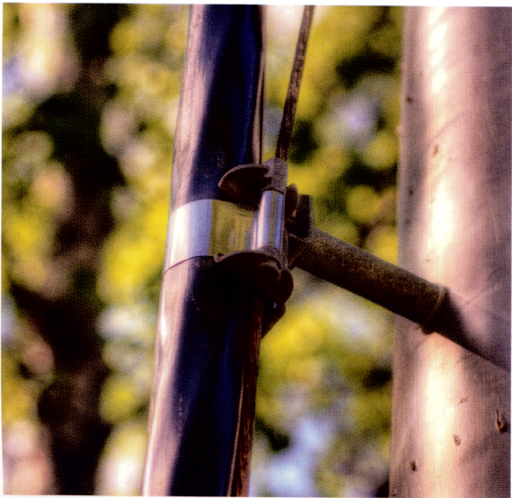
Lättjobbad stolpe. Arbetet förenklas av förinstallerad infästning för linjekrok och stag. Det går också bra att använda trästolparnas franska skruvar, bara man förborrar.
