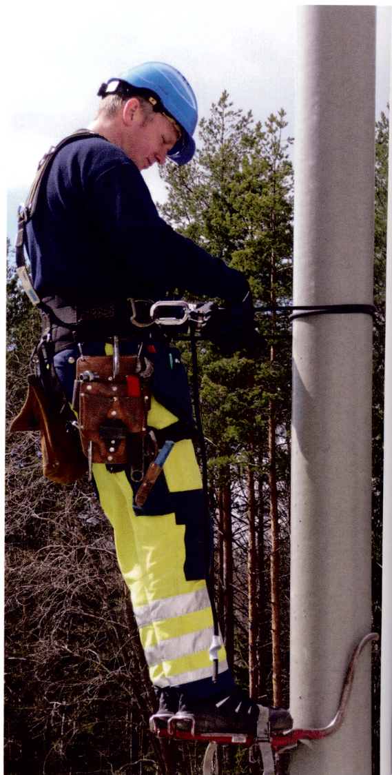
Standardlängden är 12 meter, men den kan både kortas eller förlängas. För att nå toppen kan man använda vanliga stolpskor.
