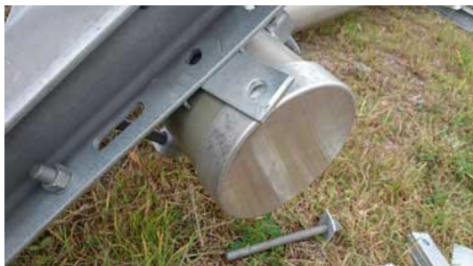
Distansbrickan monteras mellan stolpe och regel för att fjädrarna inte ska tryckas in i stolpen.
