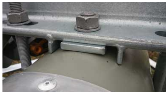
Distansbrickan förhindrar punktlaster och trycket fördelas jämt mellan distansbricka och fjädrar.
